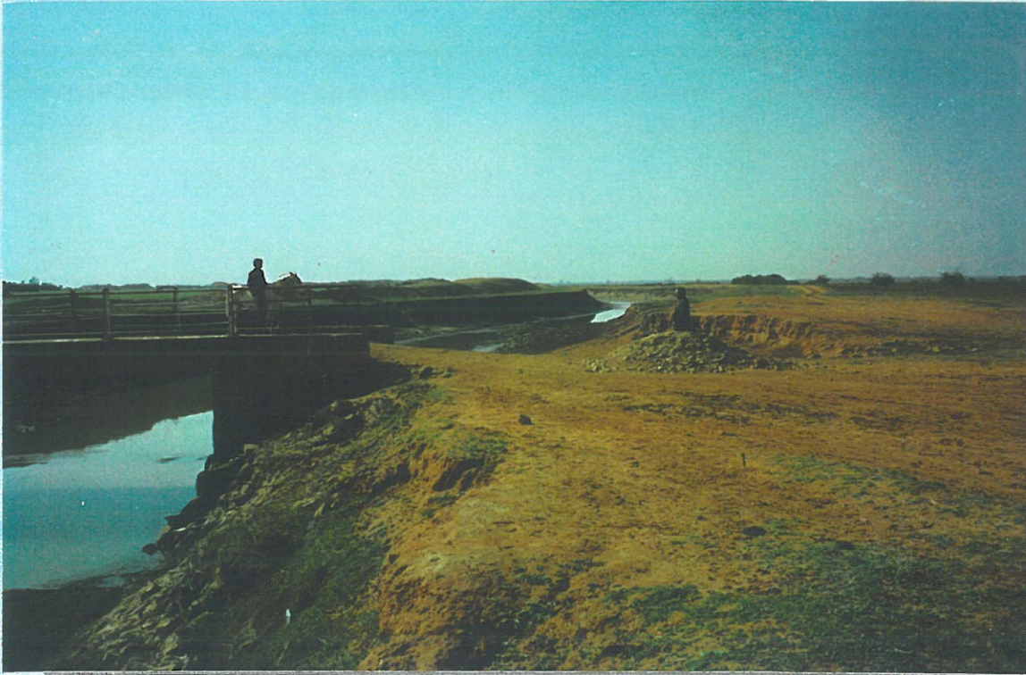
Photo prise au p.k. 43.7 (rive droite)
