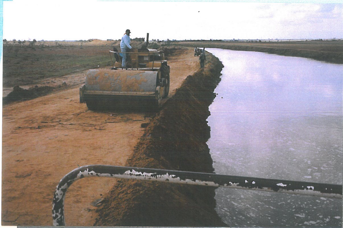
Compactage des remblais – p.k. 46.7
