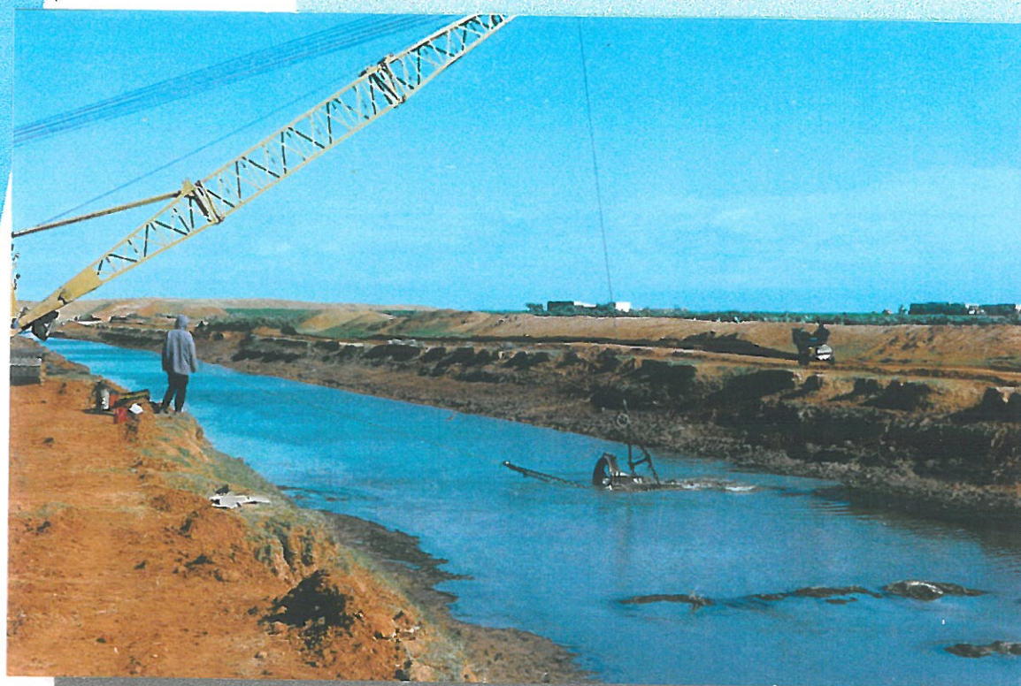
Processus du curage (cinématique pas 4) Photo prise entre p.k. 44 et p.k.45
