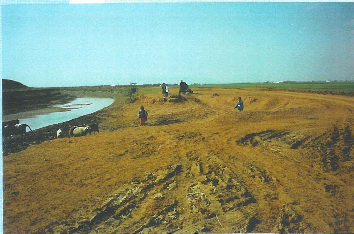
Photo prise entre p.k. 47 et p.k.48 (rive droite)
