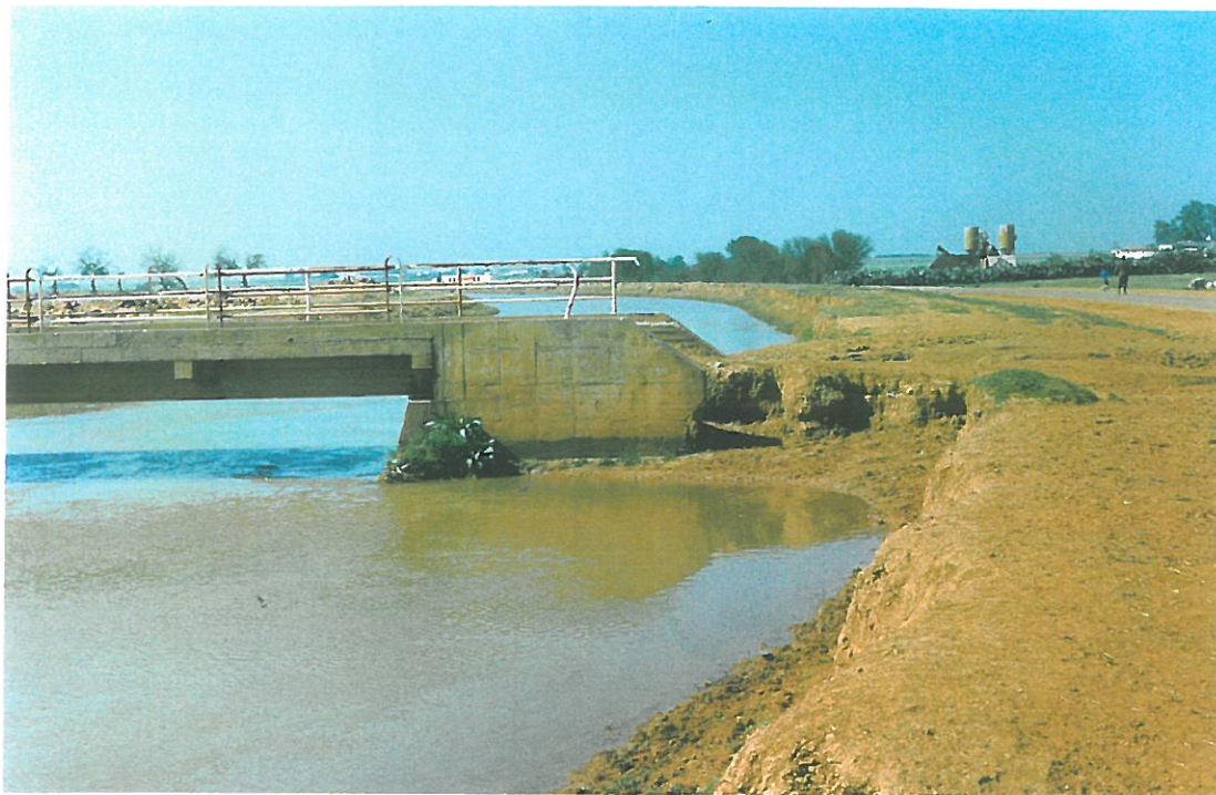
Photo prise au p.k. 79 (rive droite)
