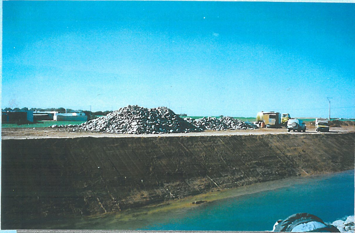
Remblais finis, vue sur le stock des matériaux Photo prise au p.k. 41.3
