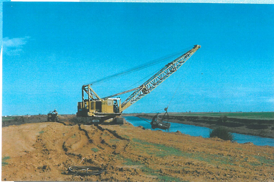
Processus du curage Photo prise entre p.k. 44 et p.k.45
