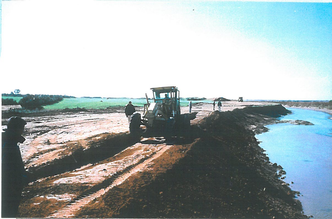
Travaux sur les remblais
