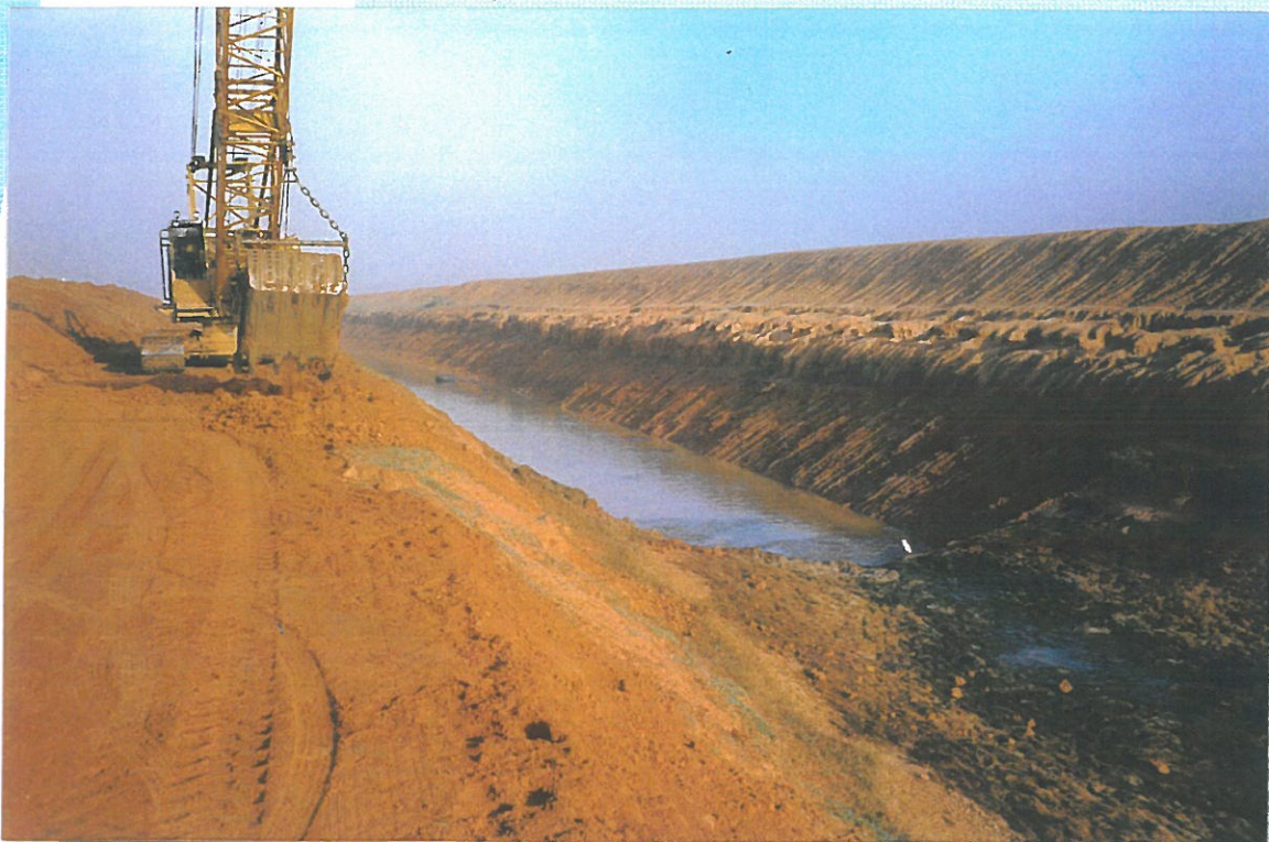
Processus du curage Photo prise au Canal d'amené
