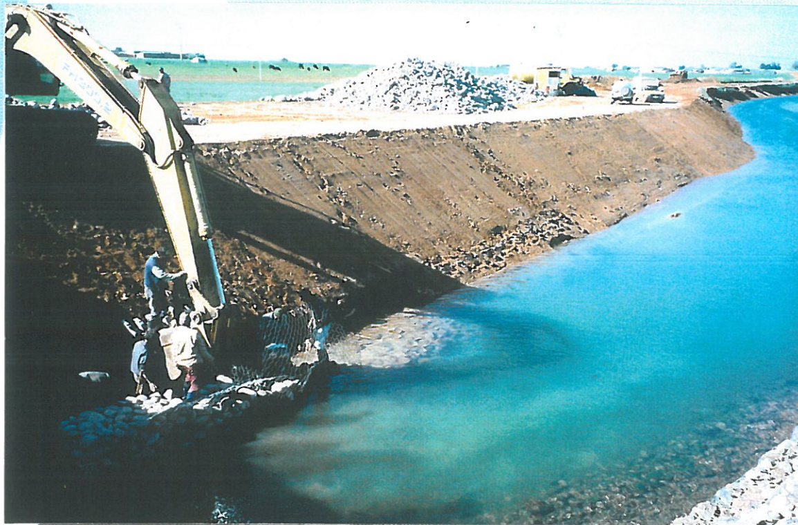
Pose des gabions Photo prise au p.k. 41.3
