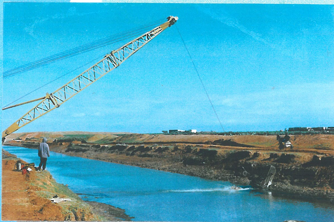
Processus du curage (cinématique pas 3) Photo prise entre p.k. 44 et p.k.45
