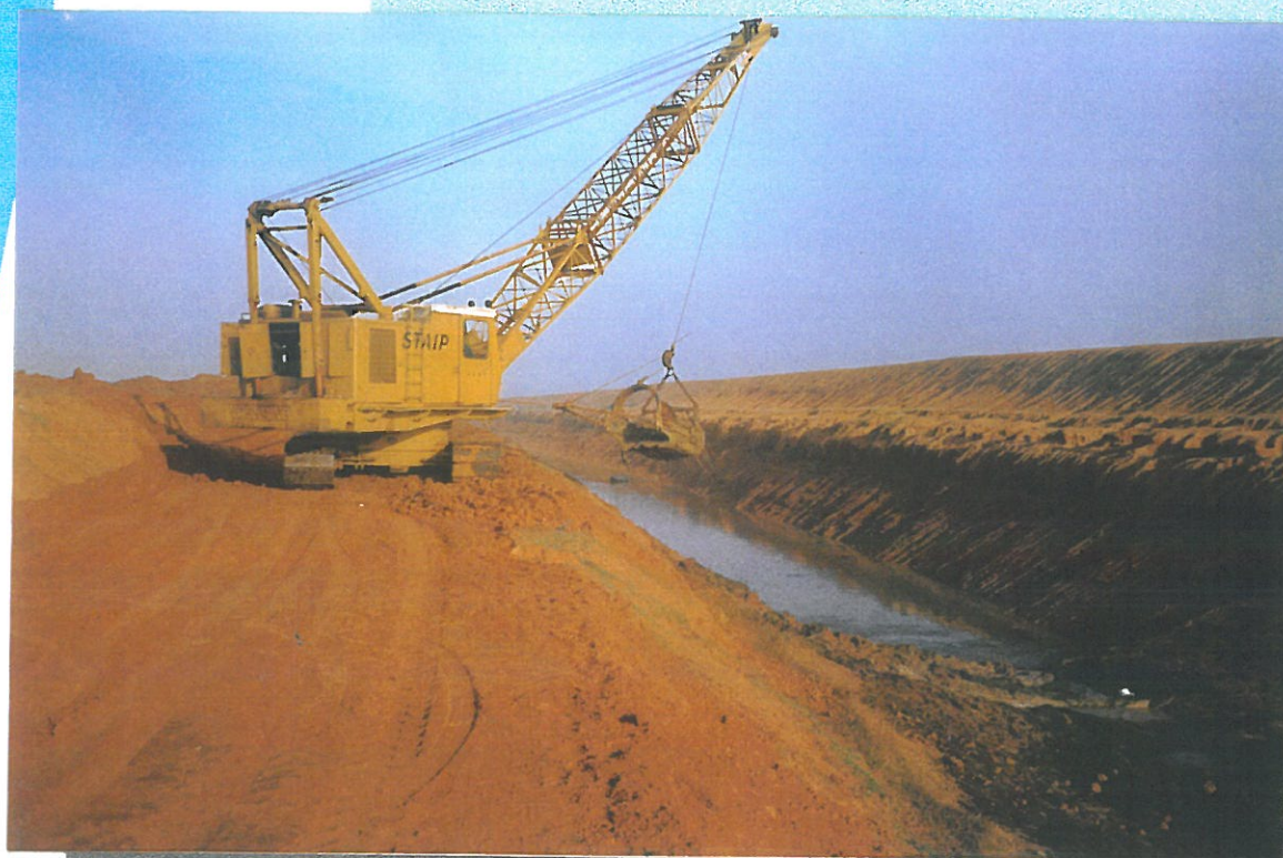
Processus du curage Photo prise au canal d'amène
