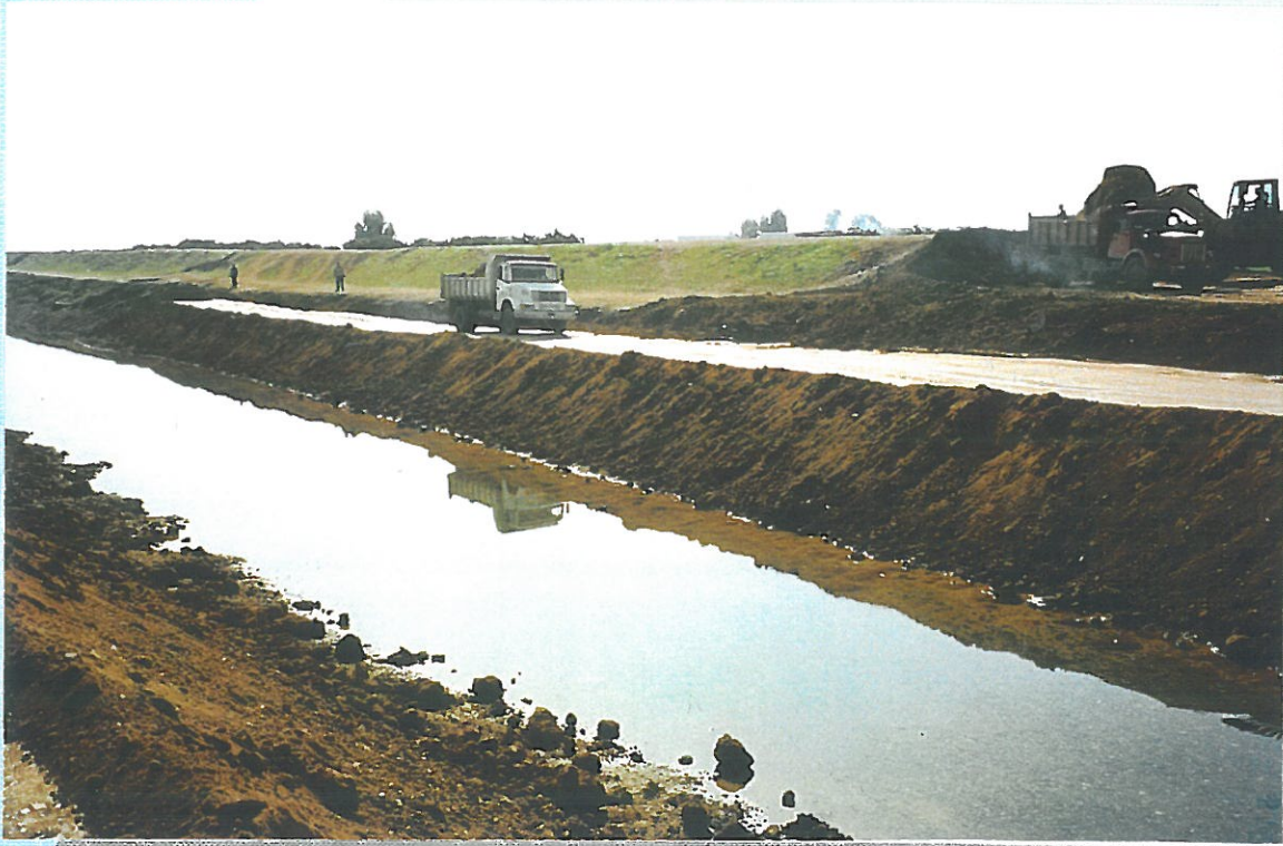
Charge des remblais
