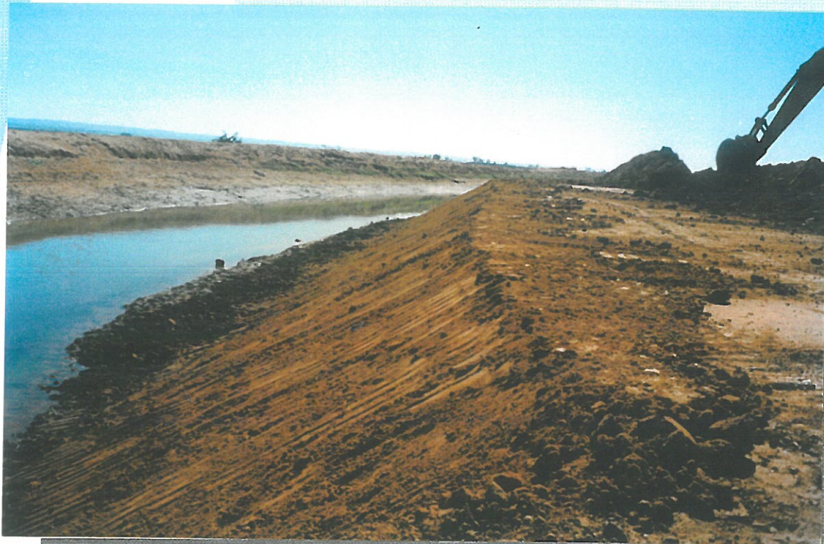
Remblais finis – entre p.k. 36 et p.k. 37
