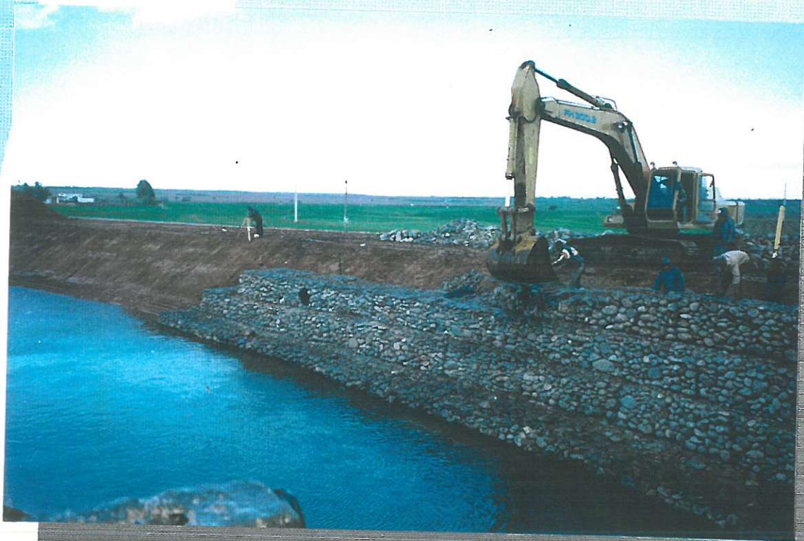
Mis en place des gabions Photo prise au p.k. 41.3
