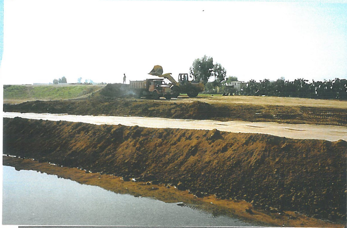
Charge des remblais
