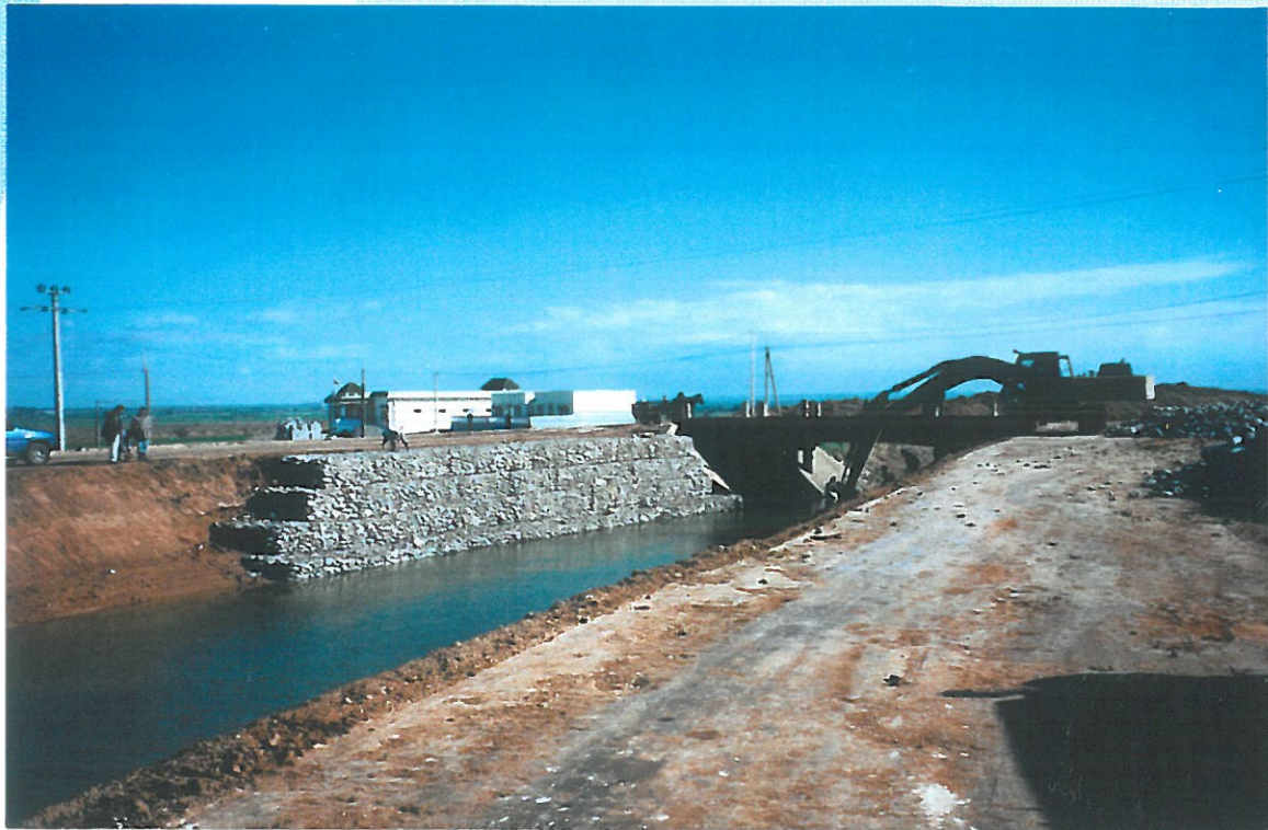
Vue sur l'ouvrage (protection de la rive droite), travaux sur la rive gauche en cours. Photo prise au p.k. 41,3
