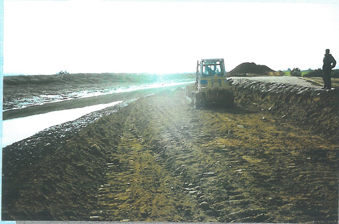
Décapage avant remblais – préparation du sol
