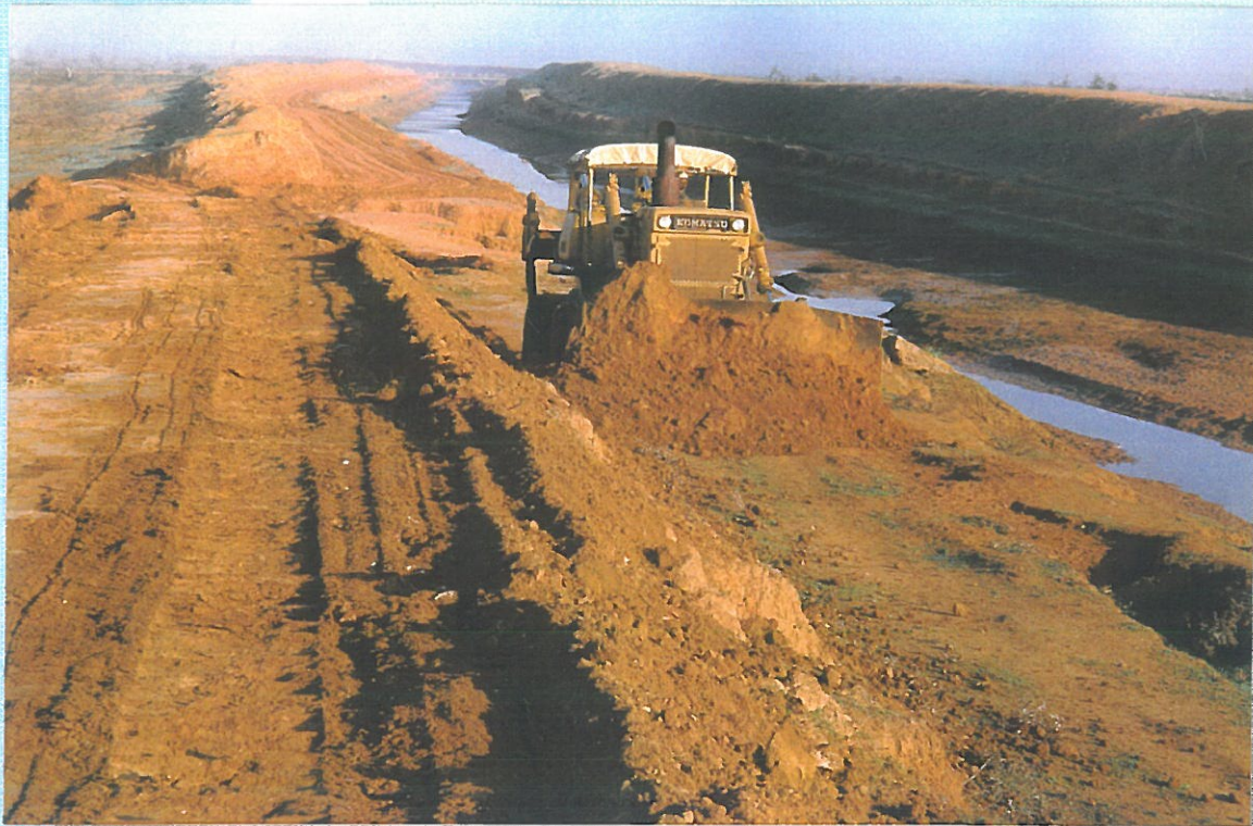
Travaux préalables pour préparation des berges Photo prise au Canal d'améné
