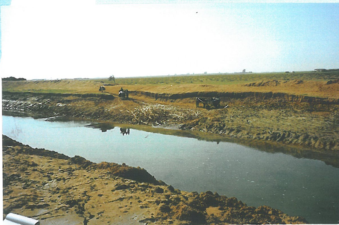
Photo prise entre p.k. 47 et p.k.48 (rive gauche)
