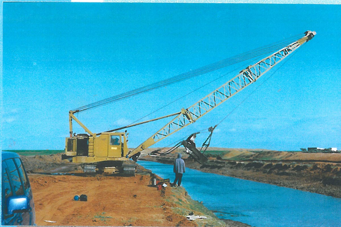
Processus du curage (cinématique pas 1) Photo prise entre p.k. 44 et p.k.45
