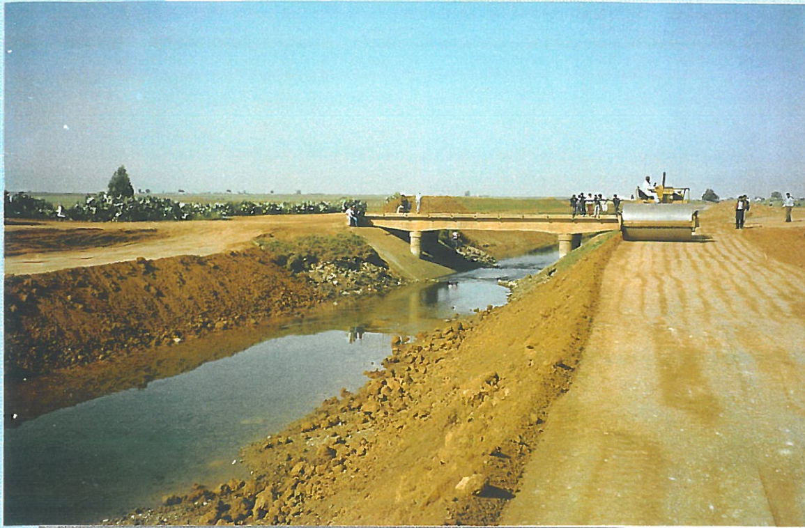
Compactage des remblais – p.k. 39
