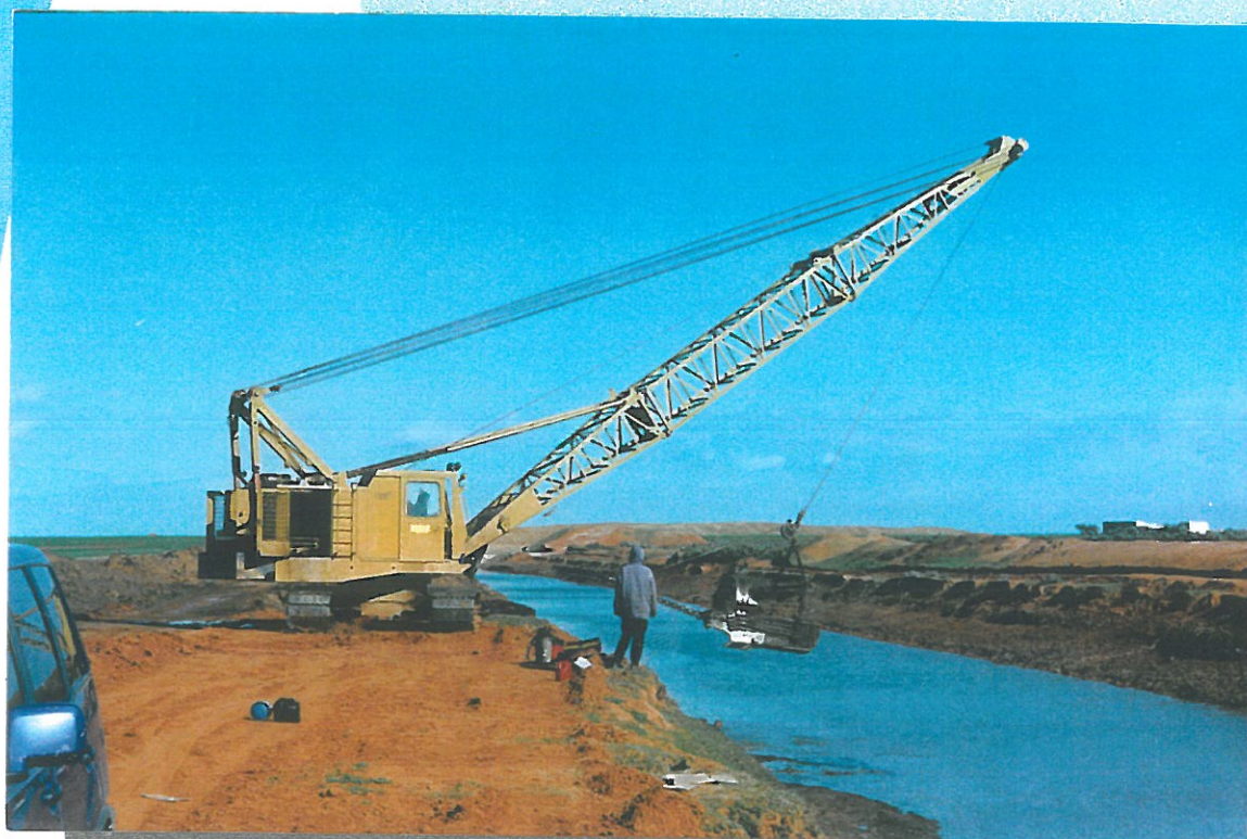
Processus du curage (cinématique pas 2) Photo prise entre p.k. 44 et p.k.45
