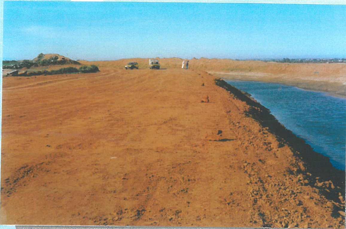
Remblais finis – p.k. 41
